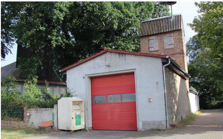
Foto Bestandsgebäude Feuerwache Beetz
