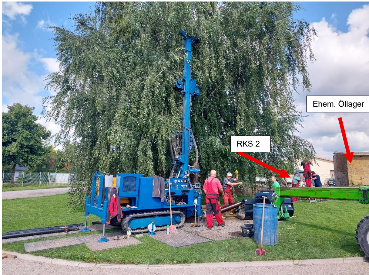
Abbildung 3-2: Messstellenbohrung mit Blick Richtung ehem. Tankstelle und Öllager
