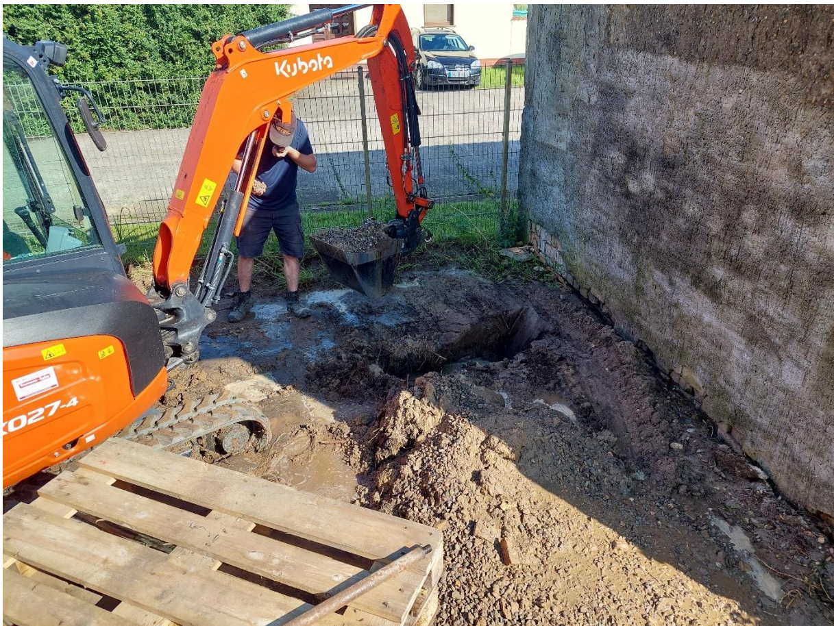
Abbildung 3-1: Wasseranschnitt innerhalb der Tankstellenwanne bereits bei 0,4 m unter Gelände
